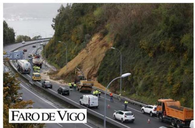
**Figura 8.** Fotografías de recortes de prensa que reflejan fenómenos de roturas circulares en taludes en jabre, típicamente denominados corrimientos de tierras, en carreteras del entorno de la ciudad de Vigo en Galicia.
