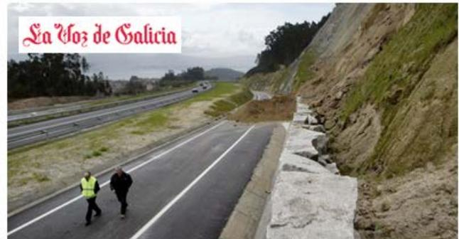
**b) Deslizamiento en jabre en la salida de Cangas en el Corredor do Morrazo, según prensa. Marzo, 2014.**
